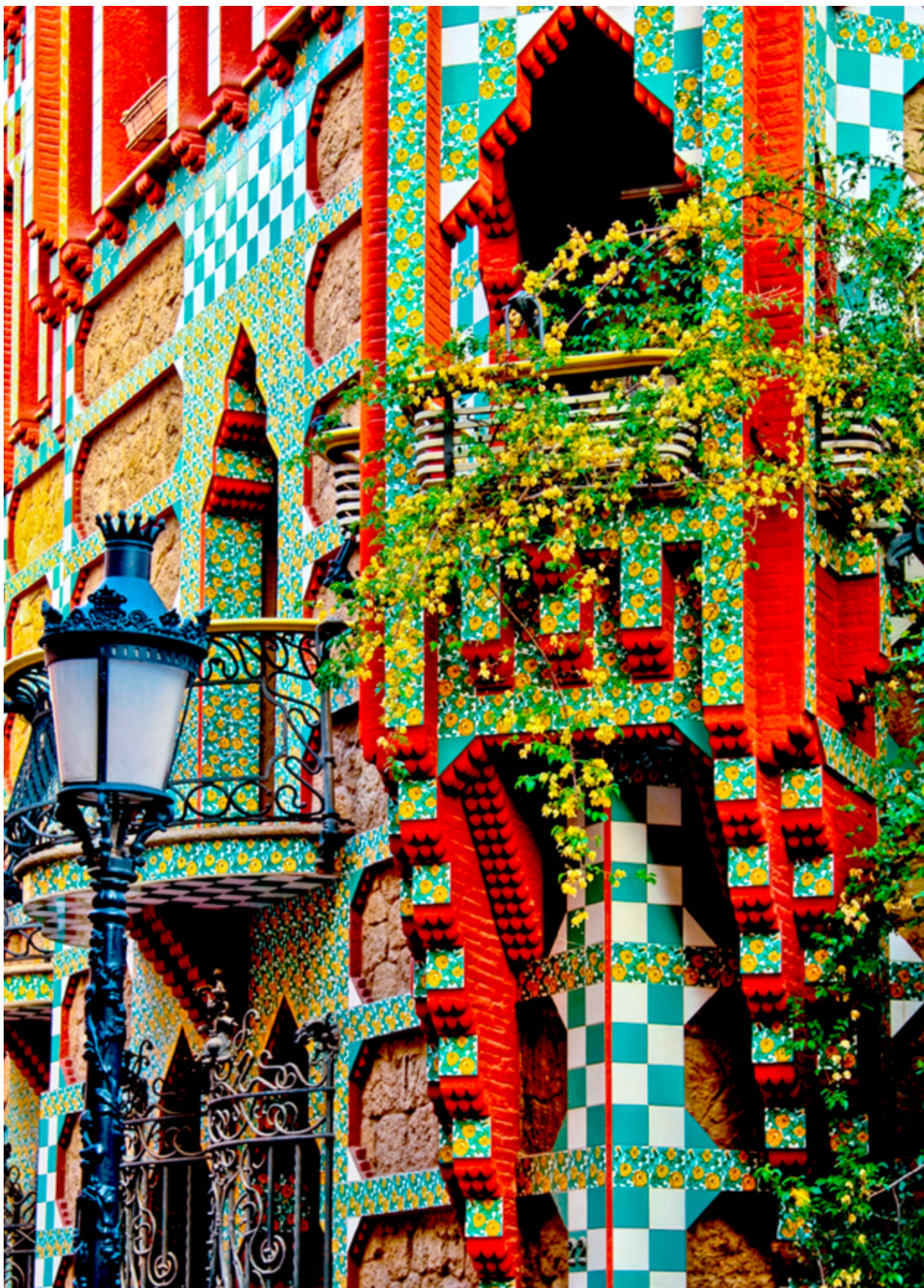
Каса „Висенс“ – фрагмент от фасадата / “Casa Vicens” – fragment of the facade
