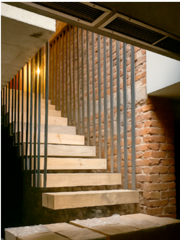
Стълба от масивни дървесни греди Staircase made of solid wood beams
