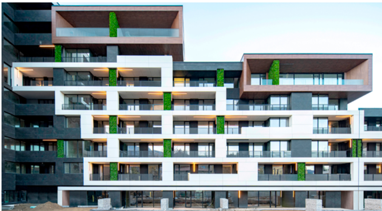
Фасада към Вътрешния двор / Facade facing the courtyard
