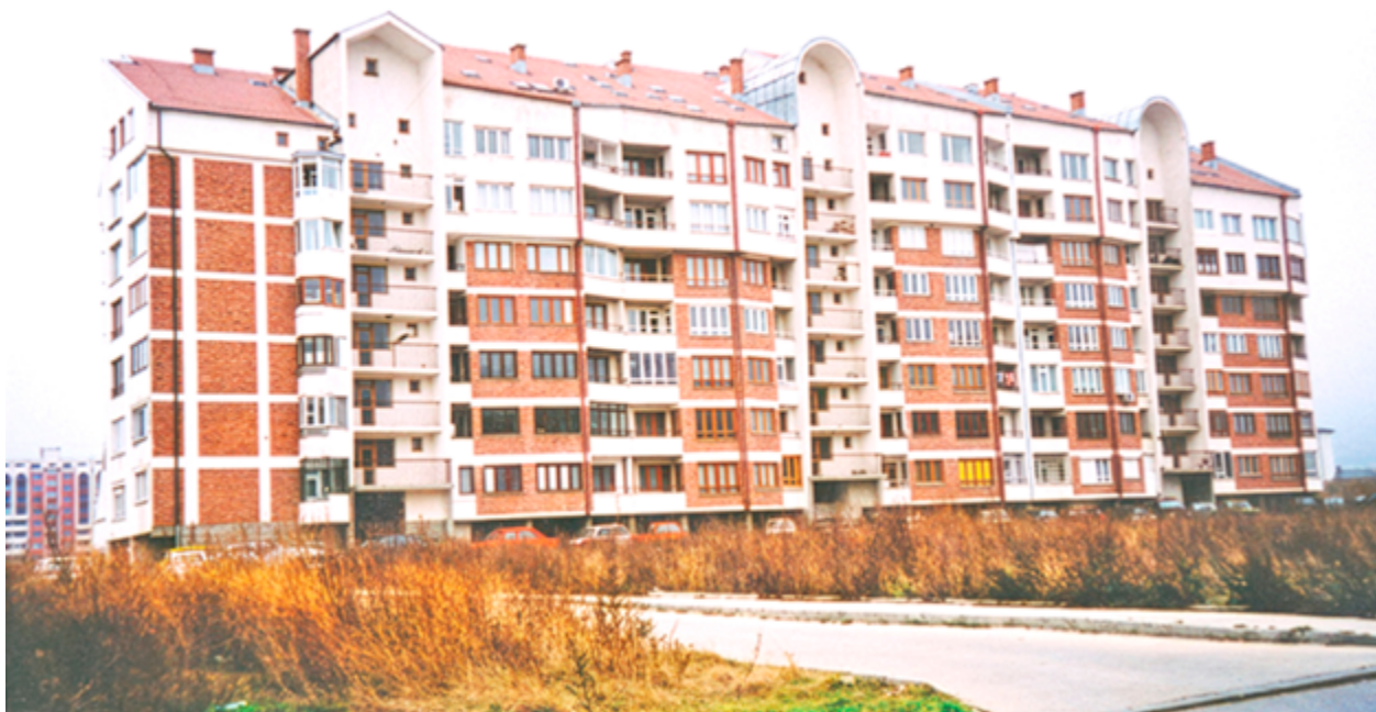
Една от жилищните сгради в жк „Малинова долина“ в София, арх. Статкова One of the residential buildings in „Malinova dolina“, Sofia, arch. Statkova
