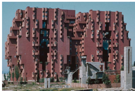
Walden 7 by Bofill Taller de Arquitectura. Sant Just Desvern. © Bofill Taller de Arquitectura
