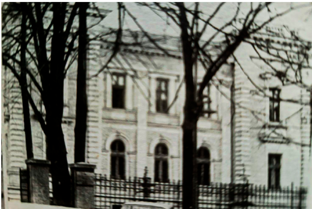
Първоначалният вид на сградата преди пристрояването и надстрояването The original appearance of the building before the addition and superstructure
