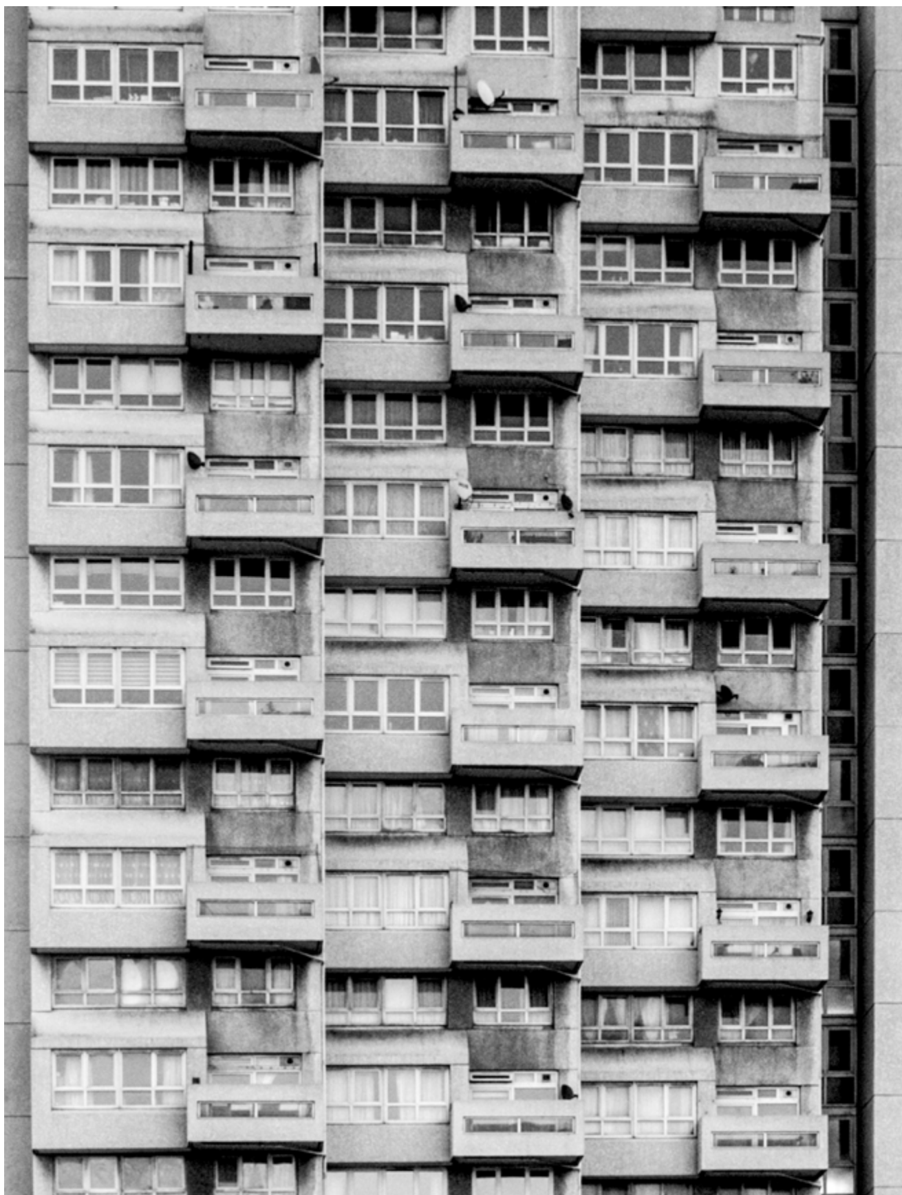
Състояние на общинския жилищен фонд в София / Condition of the municipal housing stock in Sofia
