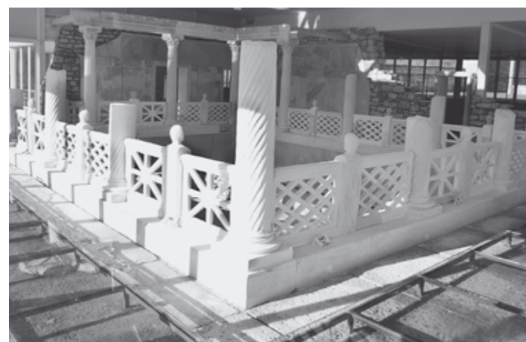
Вила „Армира“ - реставрация - арх. Ю. Фърков, 2009 г. Villa "Armira" - restoration – arch.Y. Farkov, 2009
