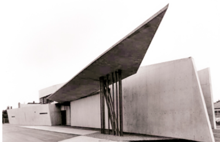
2004 Пожарна станция „Витра“, Вайл на Рейн, Германия, арх. Заха Хагуг / Vitra Fire Station, Weil an Rhein, Germany, arch. Zaha Hagug
