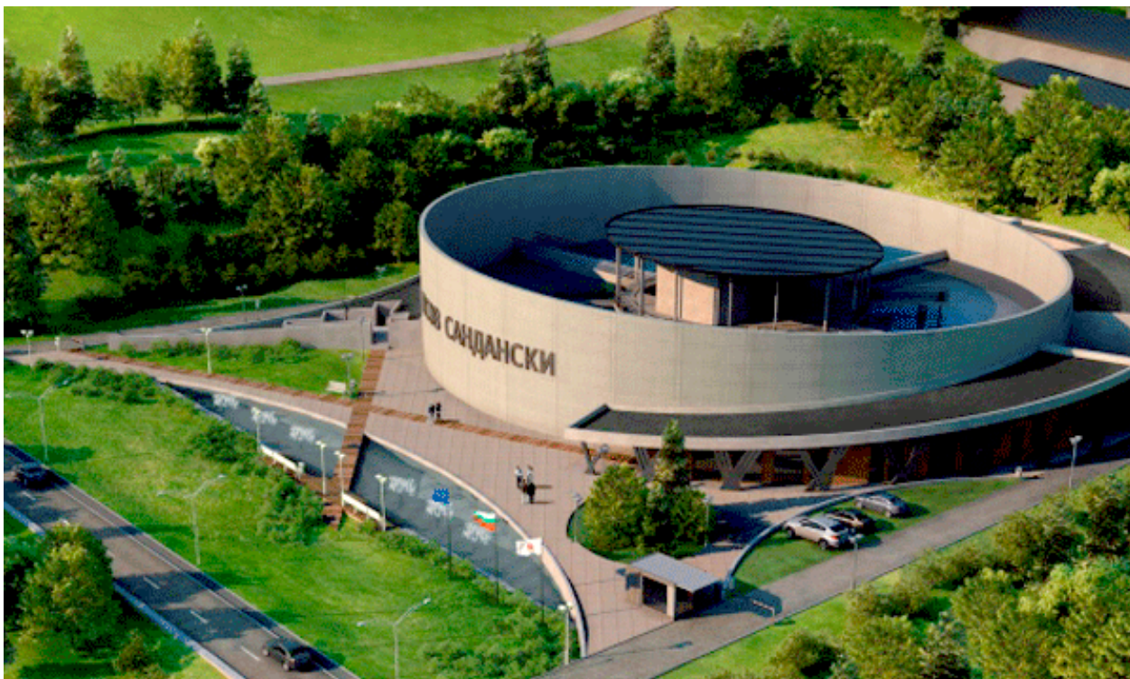
„Пречиствателна станция за отпадни води” – Сангански / "Wastewater Treatment Plant" - Sandanski
