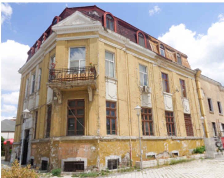
Сграда на ул. Вола №1 - преди реставрация Building at 1 Vola Street - before restoration
