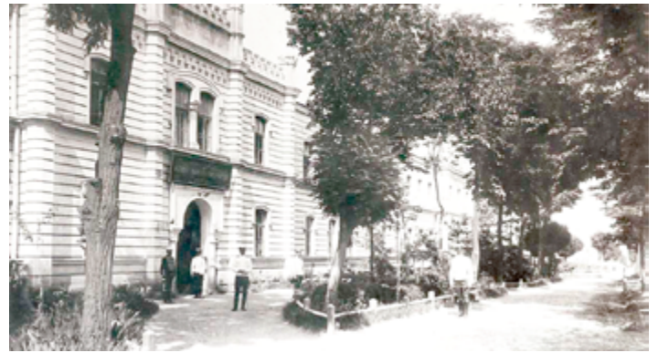
Гвардейски казарми Guard barracks
