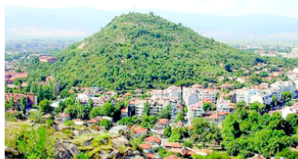
Фиг. 10. Нарушение на предписанието за ниско строителство в подножието на Бунарджик тепе в Пловдив. Fig. 10. Violation of the prescription for low-rise construction at the foot of Bunardjik hill in Plovdiv. Източник: www.marica.bg
