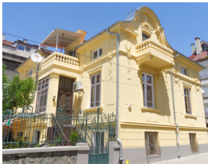
Сграда на ул. Рилска №6 - след реставрация Building at 6 Rilska Street - after restoration
