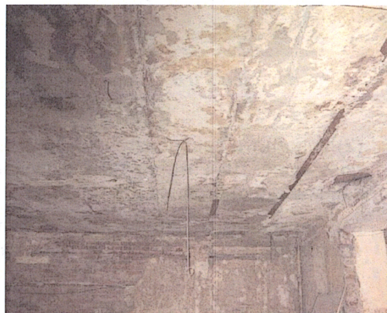
Фотоси 1 и 2. Фрагмент от поле 15-16/В-Е над 2 етаж (вляво) и от провисналото поле 1-15/Е-И, което е с отвор около 5,0м (вдясно)
