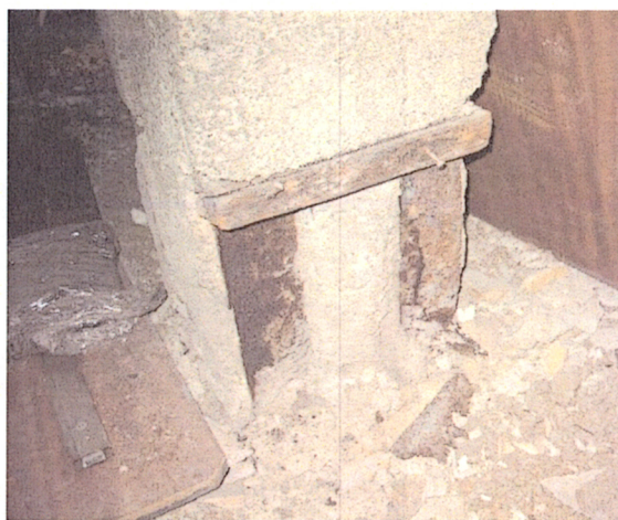
Фотоси 9 и 10. Стоманената колона в поле 15-16/В-Е на 2 етаж (вляво) и фрагмент от основата с дълбока люспеста корозия (вдясно)
