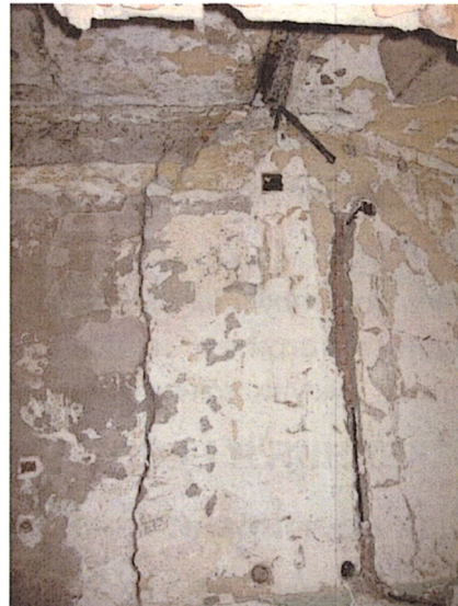
Фотоси 15 и 16. Пукнатина с широчина до 15-20mm по стената на стълбата на 1 етаж (вляво) и в коридора на 2 етаж (вдясно)
