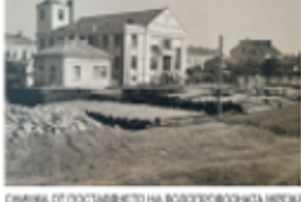
ОШИМКА ОТ ПОСТАВЯНЕТО НА ВОДОПРОВОДНИКА И ПИПЕТА НА ВУДИН 1938 PHOTO DE L'INSTALLATION DU RESEAU D'EAU ET DU VIDE 1938
