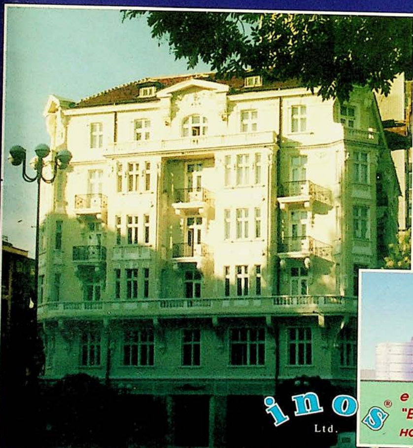
Фасада на сградата "Генович" в центъра на София. Реставрация на архитектурните орнаменти и цялостно изпълнение на нови, с използване на най-съвременни хидроизолационни, атмосфероустойчиви и консервиращи материали и технологии.
