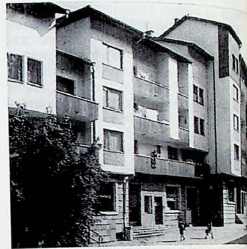
3 Жилищна група „Теодосий Търновски“ във Велико Търново. Проектант: арх. Иван Чолаков. Groupe résidentiel „Théodossi Tarnowski“ à Vêliko Tîrnovo. Projeteur: architecte Ivan Tcholakov.
