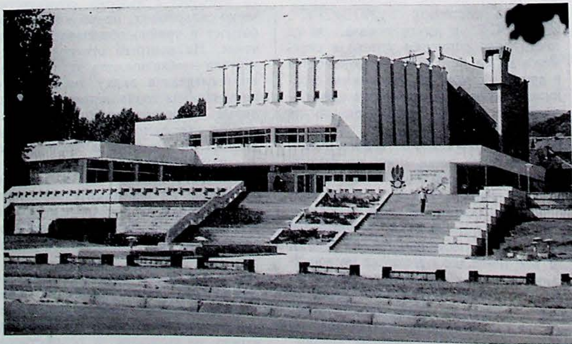
1 Културен дом в Панчарево — София. Проектант: арх. Дина Станчева. Maison de la culture à Pantcharévo — Sofia. Projeteur: architecte Dina Stantchéva.
