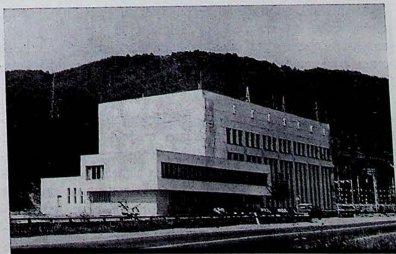
3 ВЕЦ „Момина клисура“ Centrale hydro-électrique „Momina klissoura“
