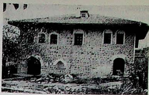
1 Арбанашка къща със скрита сантрачна система в каменната зидария Maison d'Arbanassi à système de poutres dissimulées dans les murs de pierre
