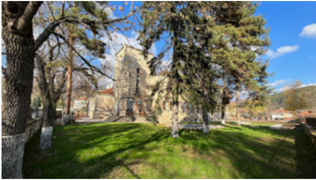
Рестаурираното училище и предната част The restored school and the front of the green park
