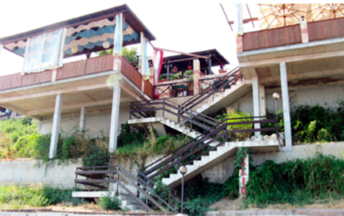
Фиг. 9: Незаконно строителство в Старинен град Несебър, Световно наследство (снимка Т. Кръстев, 2012) / Illegal construction in the Old Town of Nessebar
