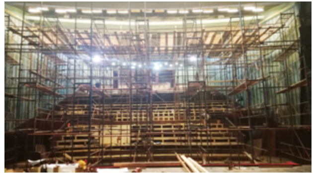
Поглед от сцената към залата по време на реконструкцията View from the stage to the hall during the reconstruction
