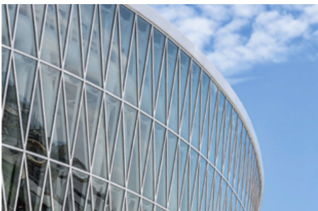
Изглед към детайл от фасадата / view of a detail of the facade
