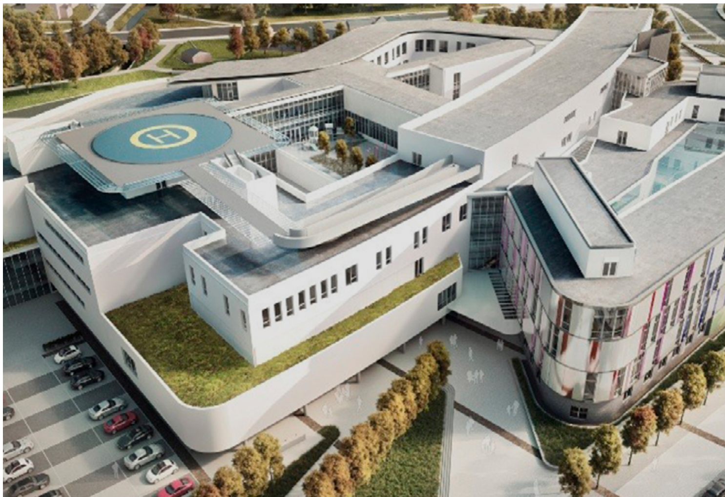
Кралската болница за деца и младежи, Единбург, Великобритания, HLM Architects The Royal Hospital for Children and Young people, Edinburgh, UK, HLM Architects
