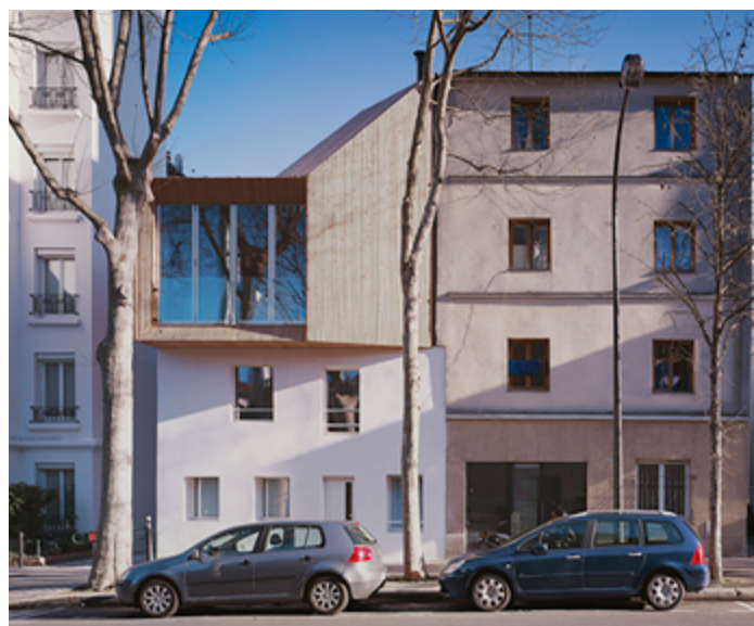
Фиг. 5. Надстройкаване на сгради, Париж / Fig. 5. Rooftop extensions, Paris
