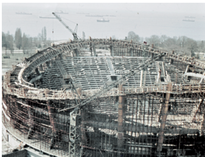
Строителство 1966 г. Construction site 1966
