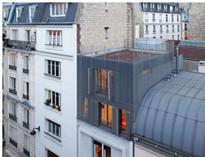
Фиг. 4. Надстройкаване на сгради, Париж / Fig. 4. Rooftop extensions, Paris
