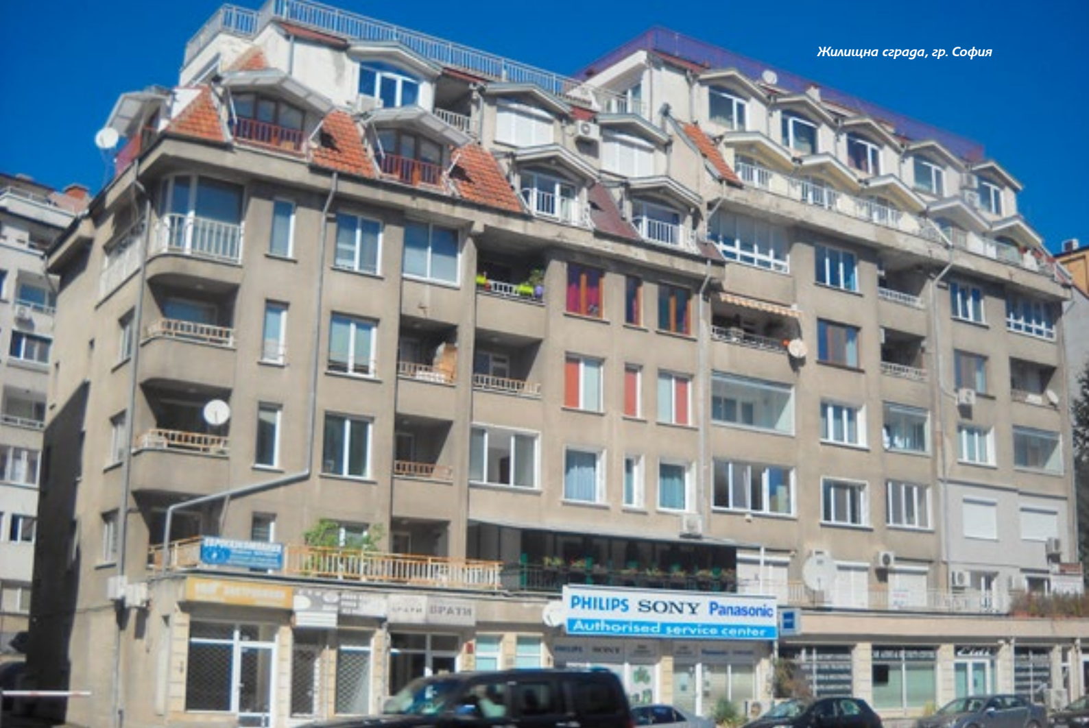
Офис-сграда, бул. Цариградско шосе, гр. София
