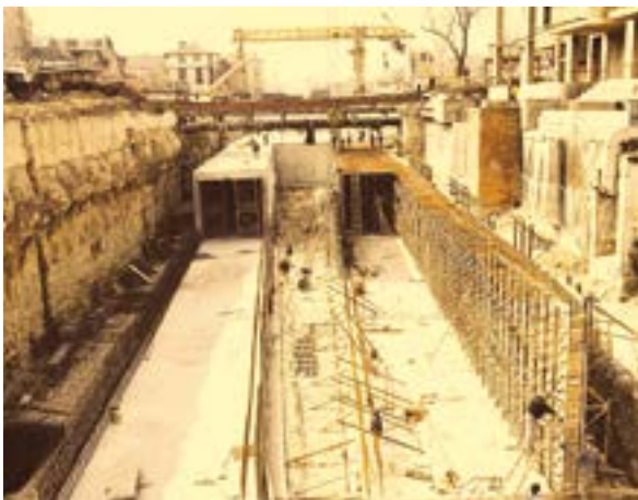
Строителство на ст. „Константин Величков“, началото на 80-те години
