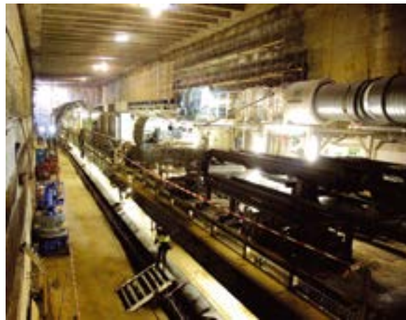
Тунелопробивната машина, с която беше изграден 7 км двутунелов път на Линия 3 от „Красно село“ до Малък градски театър „Зад канала“
