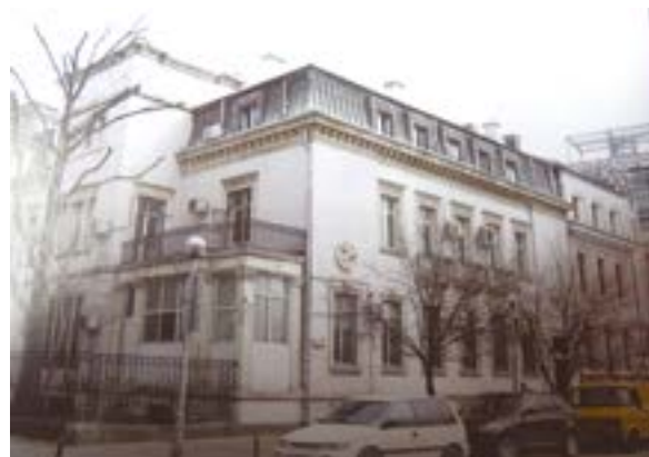
Фиг. 3 ул. „Московска“ 41, дом „Буров“, 1932-33 г., арх. С. Овчаров.
