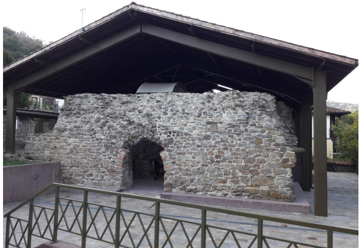
Консервация на отоплително помещение
