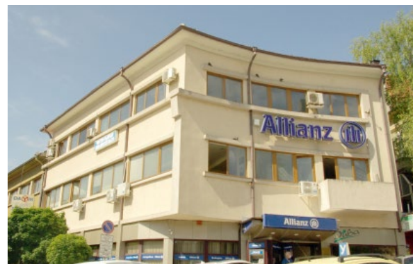
Сградта от 30-те години на ъгъла на ул. „Ивайло“ и „Марно поле“ с усвоена покривна тераса и покрита със скатен покрив
