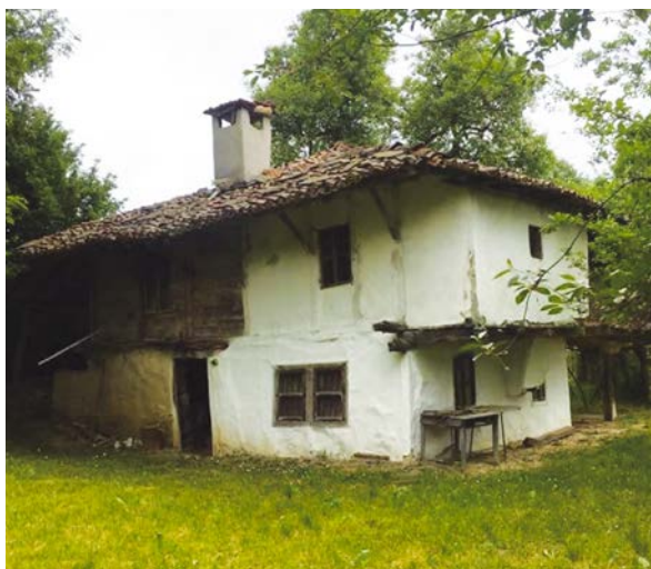
Съществуващото първоначално състояние на къщата
