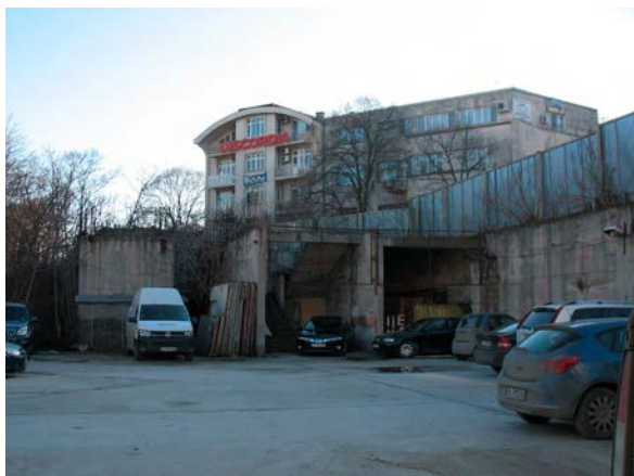
Част от незавършената стоманобетонова структура на Търговския дом.
