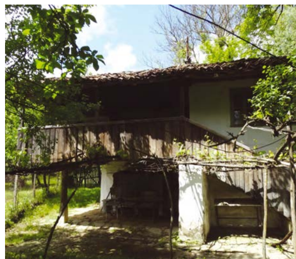
Съществуващото първоначално състояние на къщата
