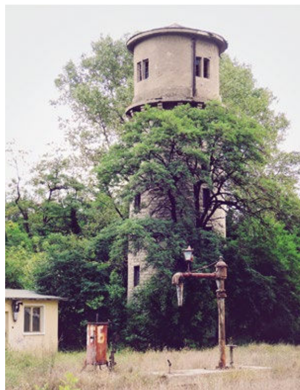
Фиг. 1. Водна кула и воден кран за зареждане с вода на парните локомотиви на гара Банско, 2014 г. Източник: https://bg.wikipedia.org , автор: Спасимир
