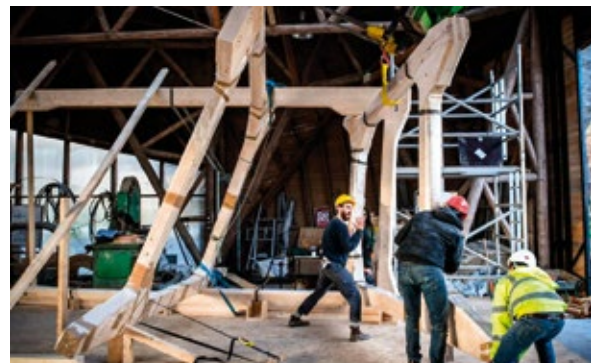
Фиг. 3. Изграждане на дървена конструкция, Хук Парк, Архитектурна асоциация – Лондон
