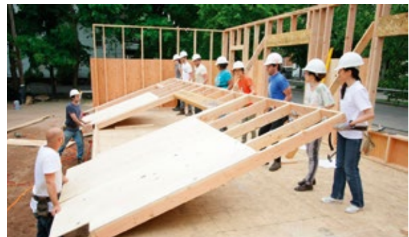
Фиг. 1. Строителство на еднофамилна къща, Yale School of Architecture, 2012.
