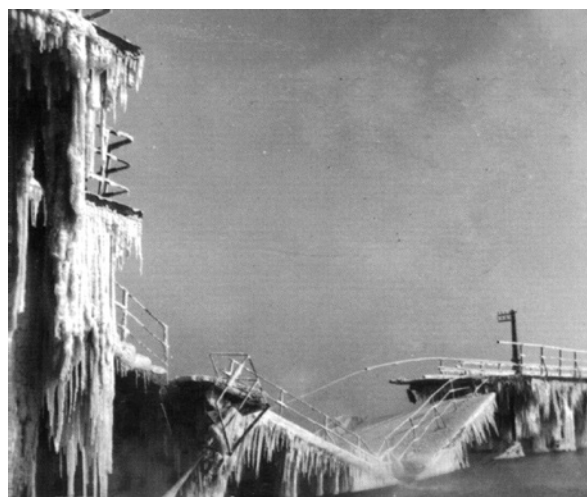
фиг. 1. Старият мост от 1933 г., полуразрушен в резултат от залежаване през зимата на 1963 г. (източник: Корудерлиева-Стоянова, К. „Памет Бургаска“, Бургас, 2015)
